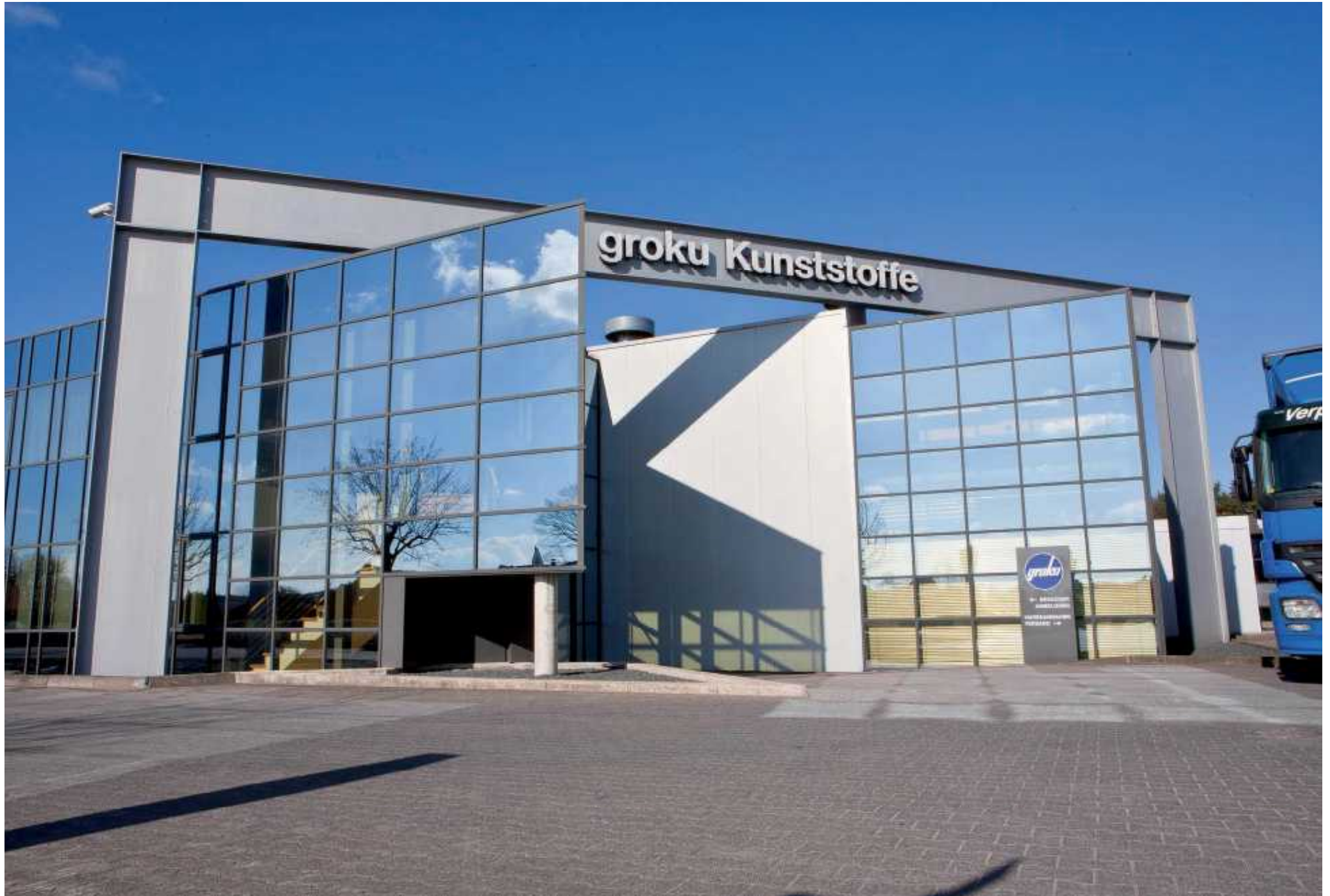
groku Kunststoffe GmbH, Verwaltungsgebäude in Schloss Holte - Stukenbrock
