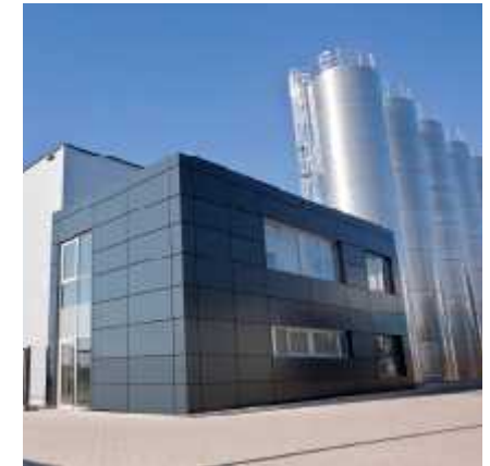
Lebensmittelhalle, Inbetriebnahme in 2010
